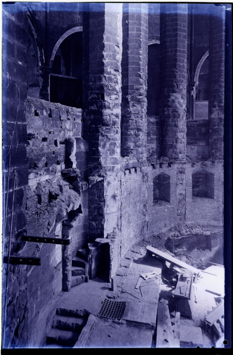
Anònim. Base de les columnes de Santa Maria del Mar. EIM000093.
